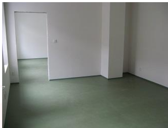
(POHLED ZE STEJNÉHO MÍSTA TĚSNĚ PŘED DOKONČENÍM REKONSTRUKCE)
