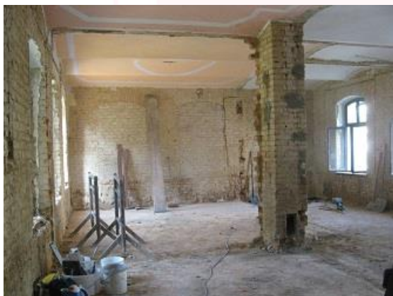
(ODSTRANĚNÍ NENOSNÝCH STĚN V PŘÍZEMÍ)
