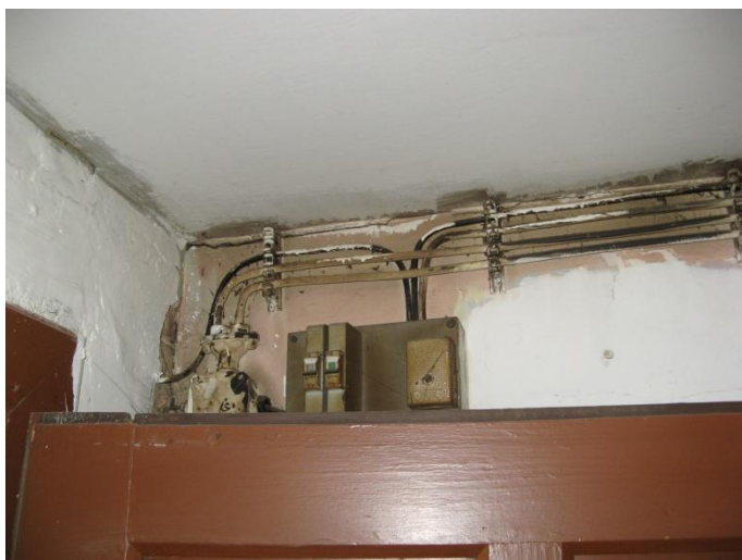
Nevyhovující elektrické vedení Nevyhovující suterén
